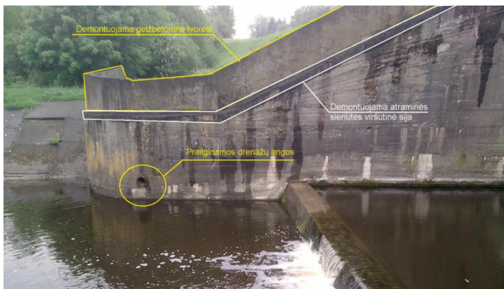
3.2.1 pav. Demontuojamos konstrukcijos
